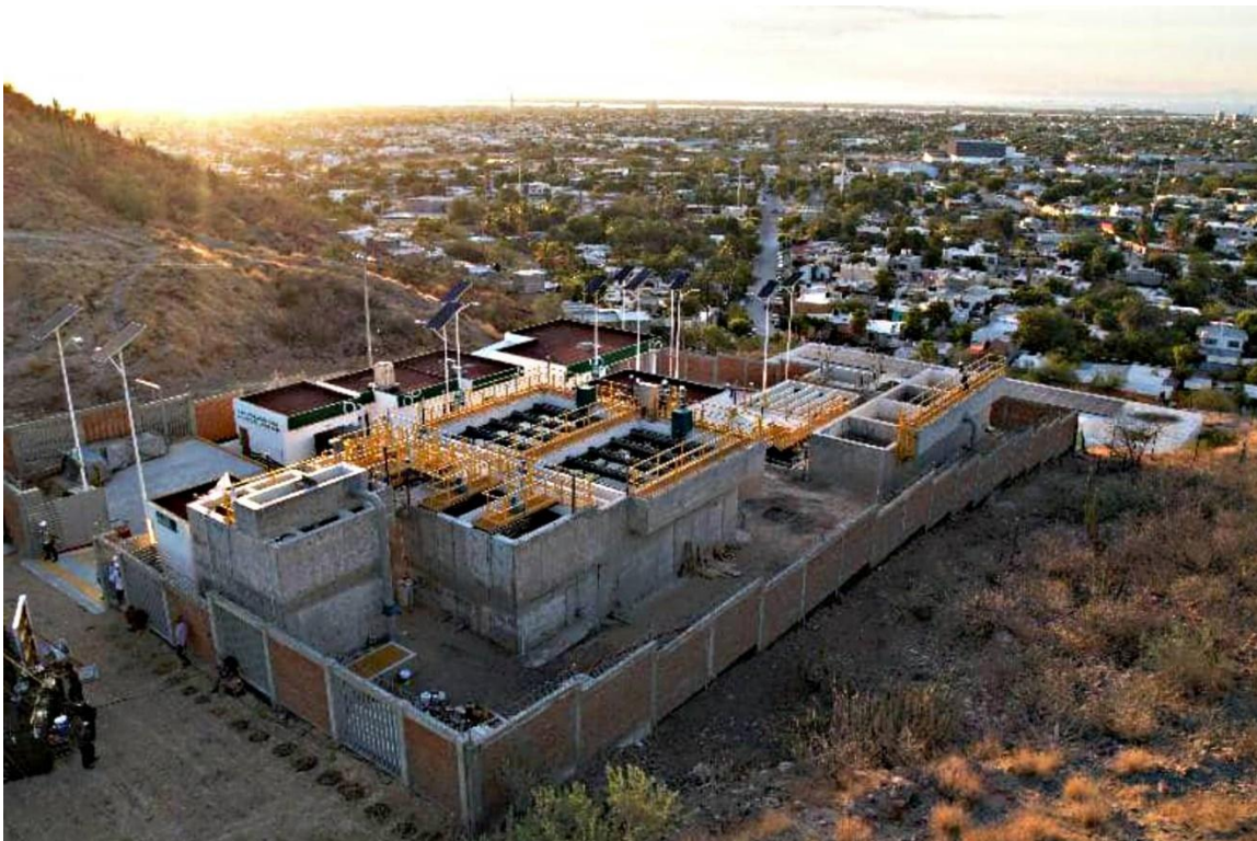
Figura 2.- Fotografía de la Planta Potabilizadora de la presa La Buena Mujer.
