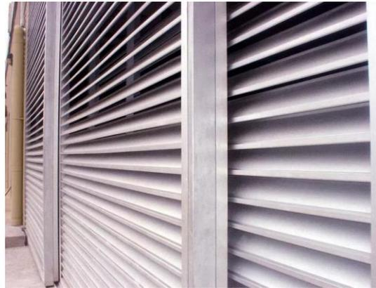
Perfiles tubulares rectangular **R-200**, a base de acero **Cal. 18** en marco y rejillas tipo Louver.
